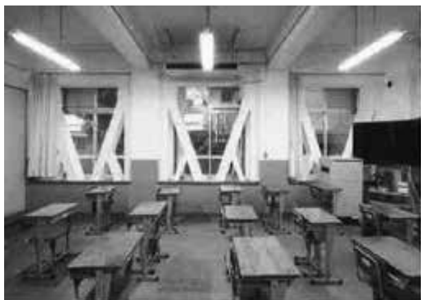
写真 近衛中学校－1～2階（鉄骨ブレース接着工法）
