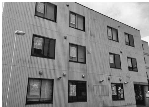
（写真1）.Make ところざわ2017の会場となった廃ビル
