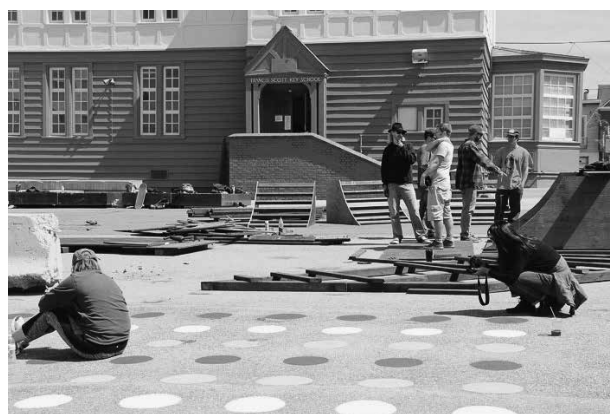
COMMUNITY WORK DAY (2016年3月)の様子 4
