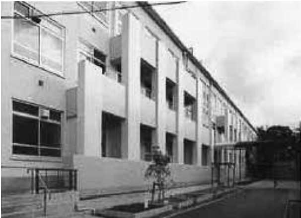
写真 鏡山小学校-1～5棟 (PCaアウトフレーム工法)
