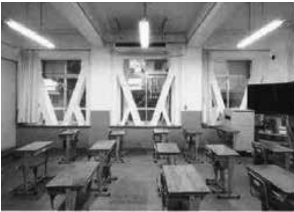
写真 近衛中学校-1～2階 (鉄骨ブレース接着工法) (出所：同前)
