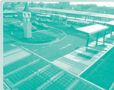
【自立型エコタウンを目指す取組】 ～東松山駅東口南側ロータリー 両面発光型太陽光パネル～
